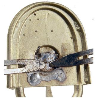
Stehkesselrückwand (T23) aufbohren (0,5mm rot 0,7 blau) und von hinten Ge- stänge (T28) einlöten.
